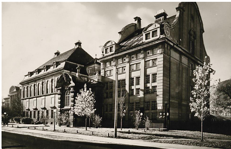
Fig. 1. La biblioteca nell'edificio originario agli inizi degli anni '40 del '900, con vista dal lato sud-est. (fonte: ULB Tirol)
